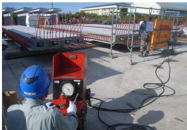
写真-2 一枚版のポストテンション状況(工場内)
