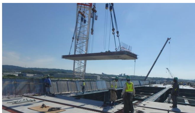
写真-3 PCaPC床版架設状況
