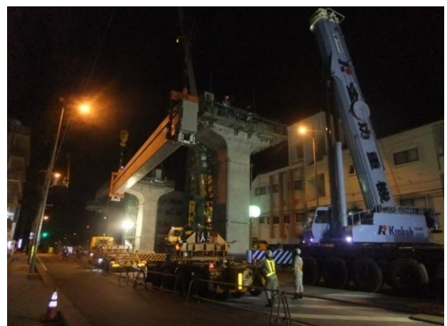
写真-6 PC 軌道桁 架設状況
