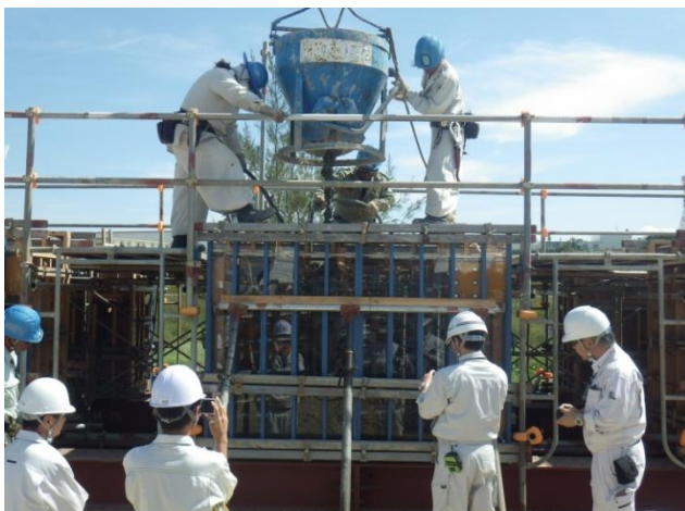
写真-4 フライアッシュコンクリート打設施工試験
