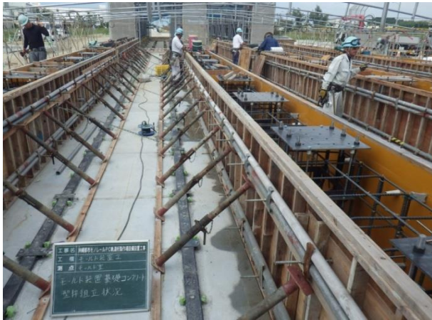
写真-3 モールド支柱基礎施工状況
