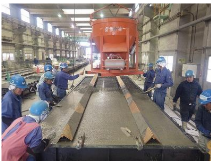
写真-3 コンクリート打込み状況
