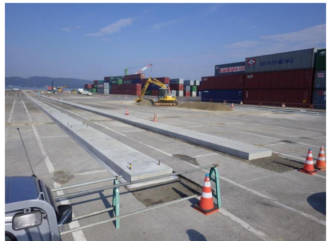
写真-3 縦行路 PPC 版完了時全景
