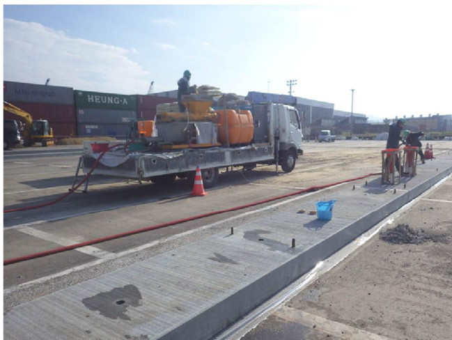
写真-2 裏込めグラウト注入状況
