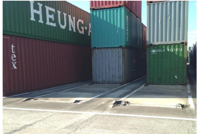
写真-1 アスファルト舗装面の沈下
