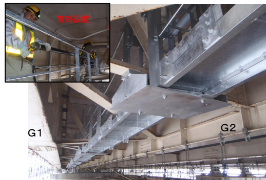
写真-5 検査路設置状況
