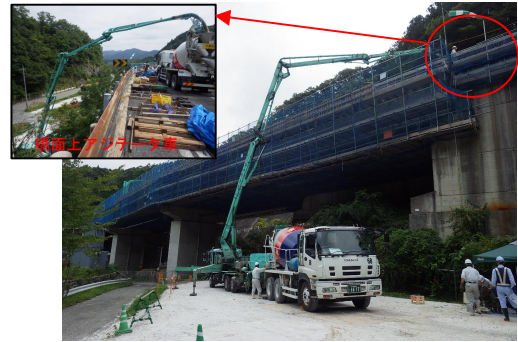
写真-2 本施工生コン荷揚げ状況
