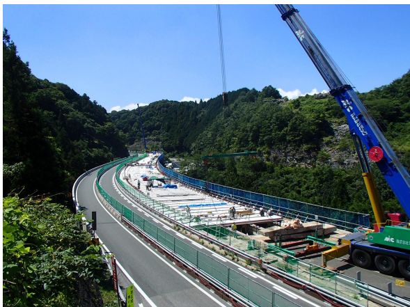
写真-1 施工状況
