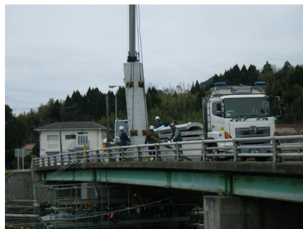
写真-5 プレキャストパネル架設状況
