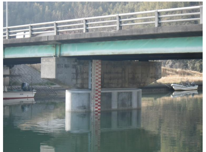
写真-1 日吉橋完成
