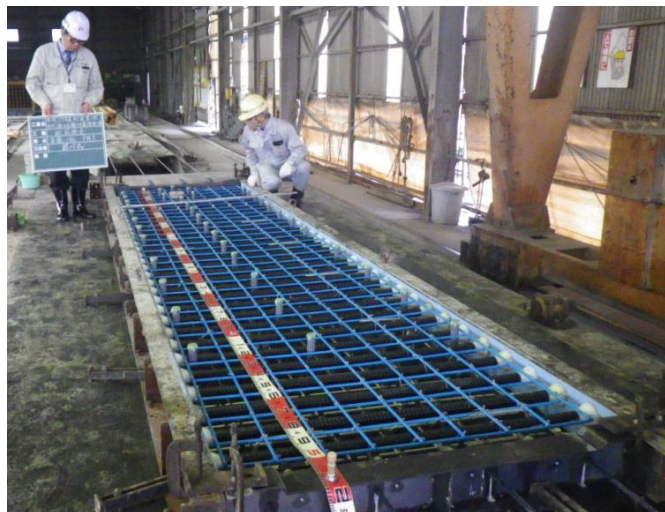
写真-2 パネル製作状況
