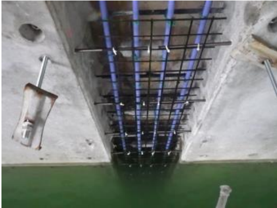
写真-3 高強度メッシュカーボン配置状況
