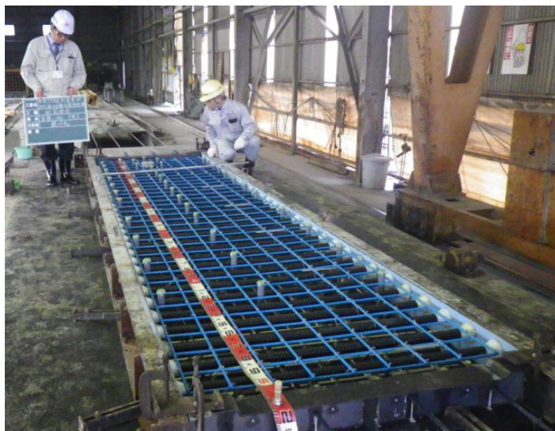
写真-2 プレキャストパネル製作状況
