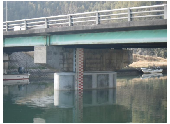
写真-1 日吉橋完成写真
