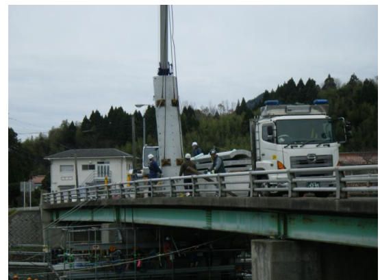
写真-5 プレキャストパネル架設状況
