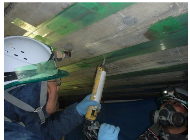
写真-3 陽極後埋め状況
