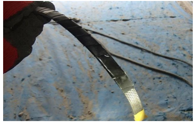
写真-2 かぶり不足部設置用陽極
