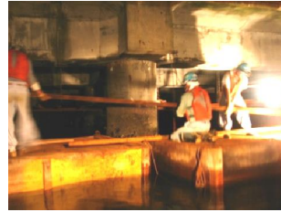
写真-4 角鋼管設置
