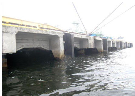
写真-1 栈橋全景
