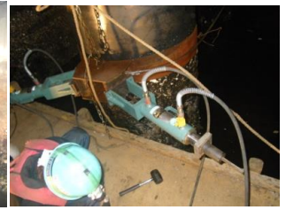
写真-3 PC ケーブル緊張
