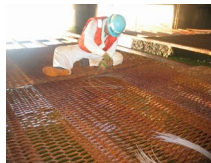
写真-6 エクスパンドメタル設置
