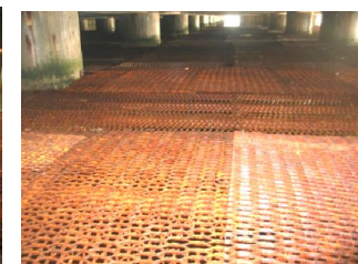
写真-7 PC 足場設置完了
