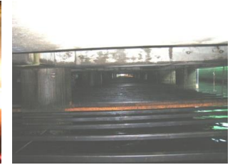
写真-5 角鋼管設置完了
