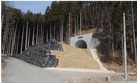
写真-1 起点側完成全景
