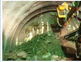
写真-4 鏡注入ボルト施工状況
