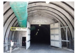
写真-5 防音屏設置状況
