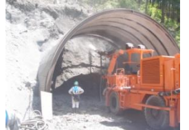
写真-3 鏡吹付け状況
