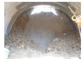
写真-2 坑口部切羽状況
