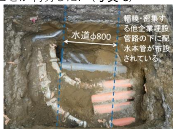
写真-3 狭隘部試験掘り
