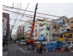
写真-7 路上作業全景
