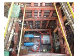
写真-8 発進立坑内
