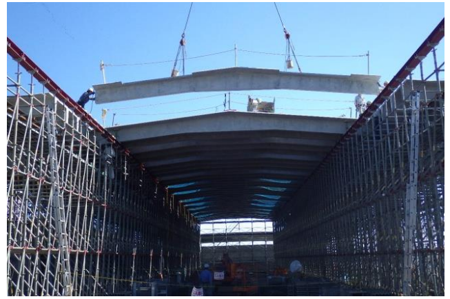
写真-3 PC床板架設状況
