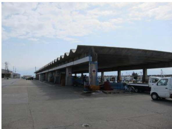
写真-1 旧荷捌き施設
