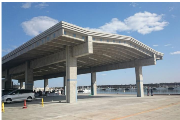
写真-2 新建物完成写真
