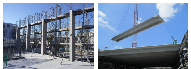
写真-4 PCa部材施工状況
