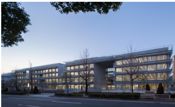
写真-1 建物外観
