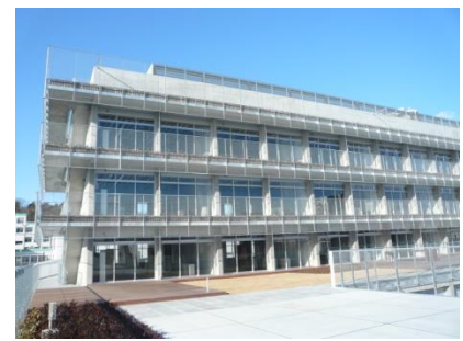
写真-3 細柱からなる鉛直フレーム (図-2の矢視①)
