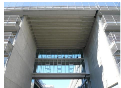
写真-5 渡り部分のエクspansion・ジョイント (図-2の矢視③)
