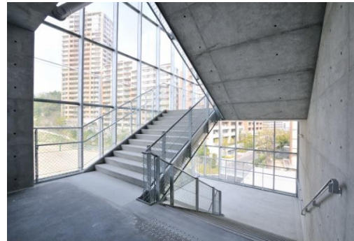
写真-20 踊場部片持ちスラブ竣工時状況
