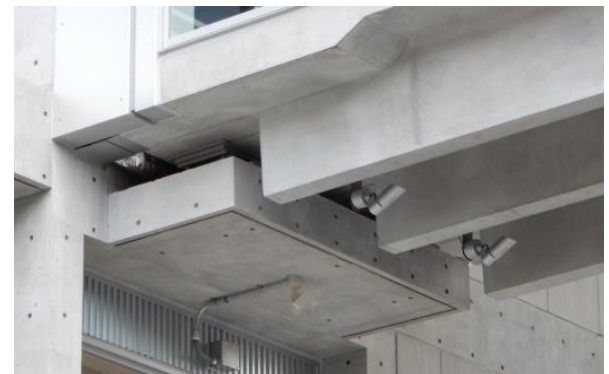
写真-7 渡り廊下支承部
