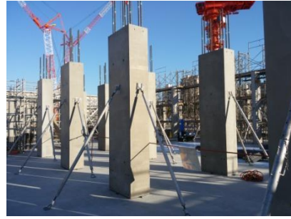
写真-14 PCaRC 柱建方状況
