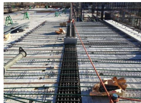
写真-18 アンボンド PC 鋼より線の配置
