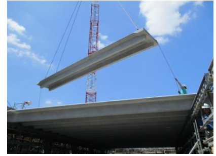
写真-15 リブ付 PC スラブ架設状況
