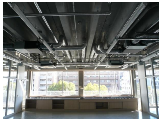
写真-12 設備配管施工後状況
