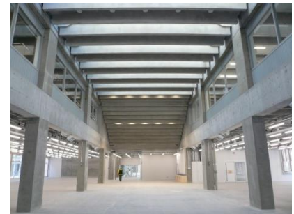
写真-4 耐震フレームとリブ付PCスラブ (図-2の矢視②)
