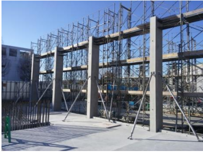
写真-13 PCaPC 細柱建方状況
