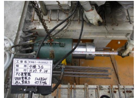
写真-16 後施工区間緊張状況
