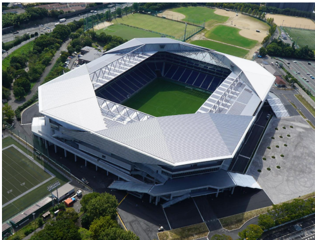
写真-1 完成写真
