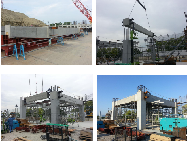
写真-2 コンコース部施工状況
