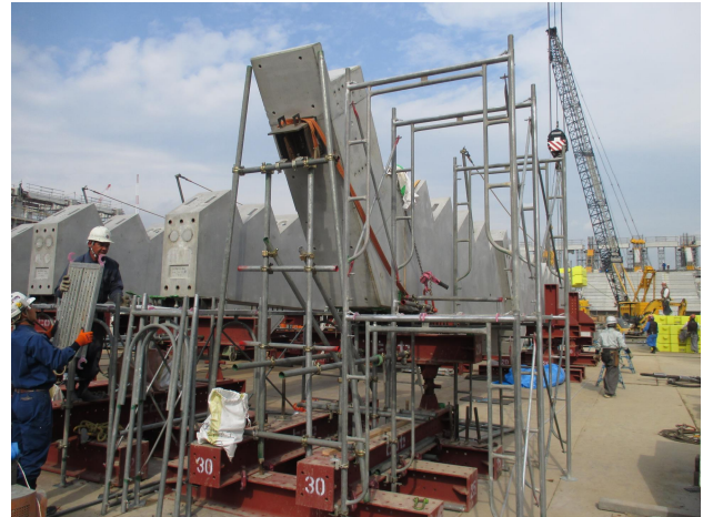
写真-9 サイトPCa部材取付完了
