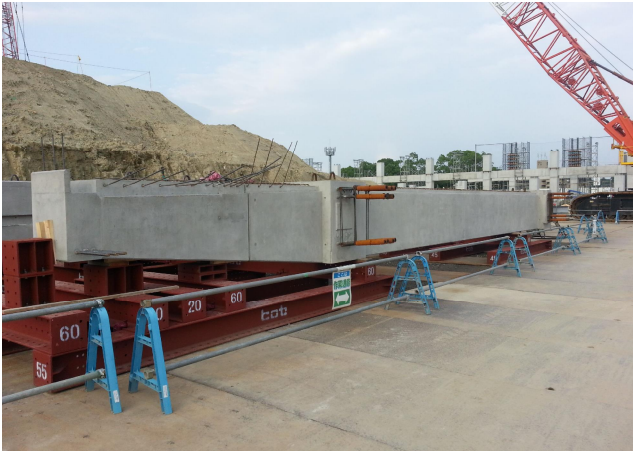
写真-2 先端梁一体化状況
