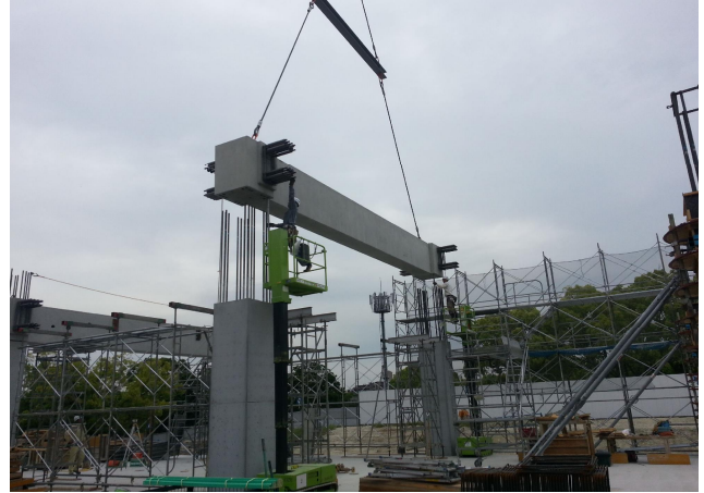
写真-3 レンコン梁架設状況
