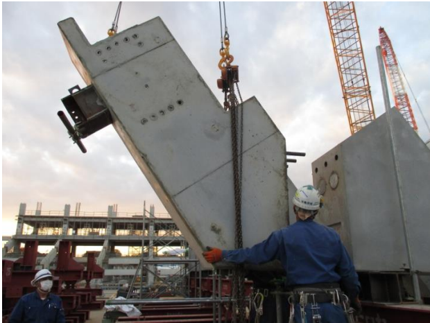
写真-8 サイトPCa部材取付状況
