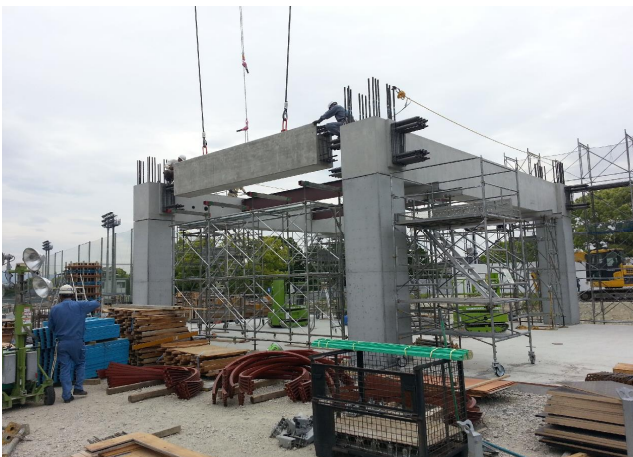
写真-4 桁梁架設状況
