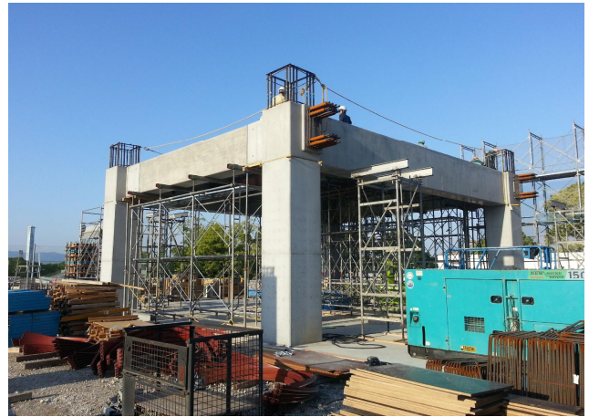
写真-5 コンコース部架設完了
