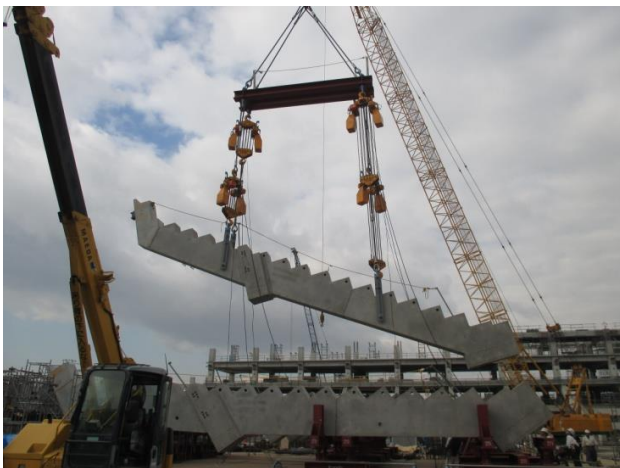
写真-10 PCaPC段梁架設状況（標準タイプ）
