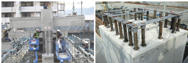
写真-2 PC 圧着レンコン梁 写真-3 レンコン柱型天端面
