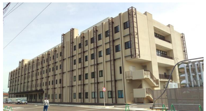
写真-1 新病院の外観 (北西面)
