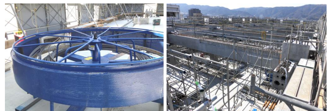
写真-4 ターンテーブル設置状況 写真-5 柱・梁架設時全景
