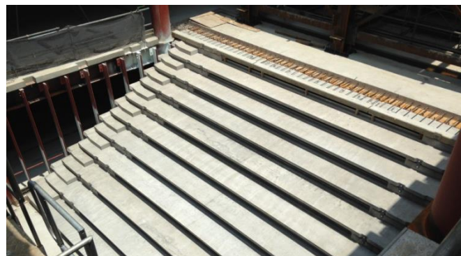
写真-4 施工時状況 (2~3 階 PC 階段版架設完了後全景)
