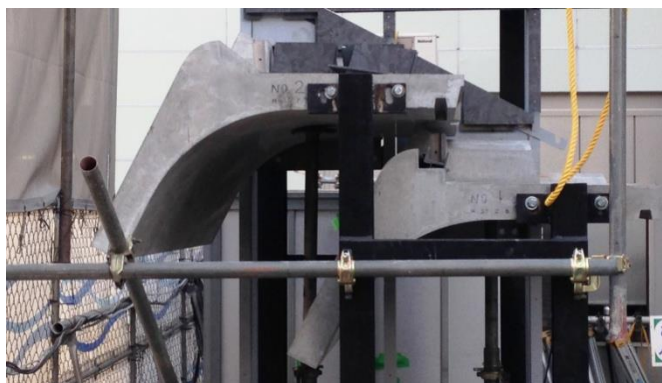
写真-3 モックアップ部材の据付け状況
