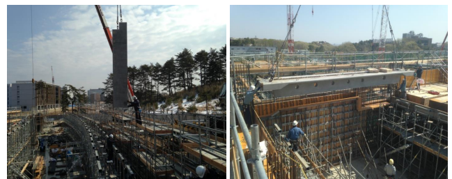
写真-5 柱架設作業状況
