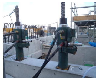
写真-7 緊張作業状況
