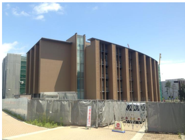
写真-1 南棟外観 (南面)
