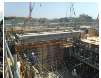
写真-6 床版架設作業状況
