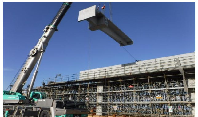
写真-8 PC 梁(庇付)架設状況
