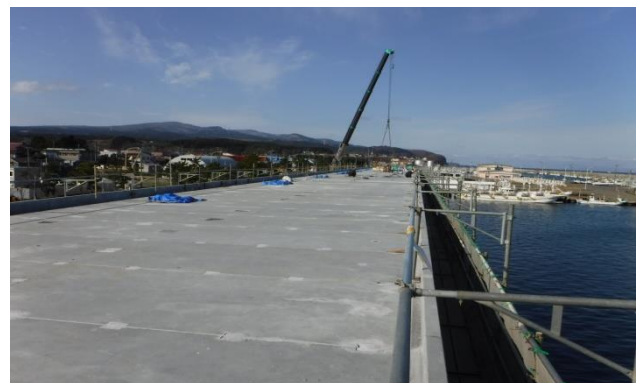
写真-9 PC 梁(庇付)架設後上部状況
