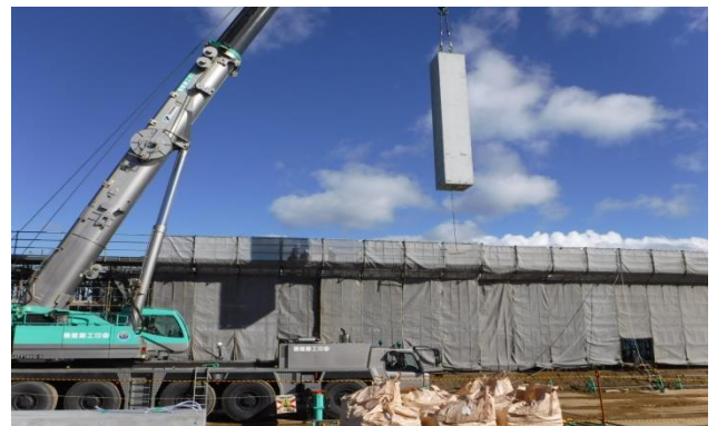
写真-7 PC 柱架設状況
