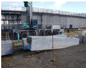
写真-5 PC 柱仮置き
