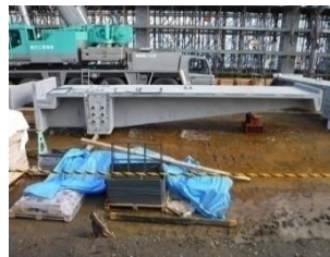
写真-6 PC 梁(庇付)仮置き
