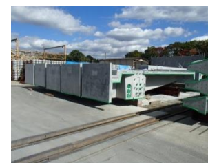
写真-4 PC梁(庇付)仮置き
