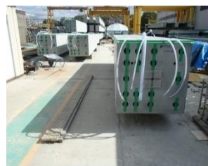
写真-3 PC柱仮置き
