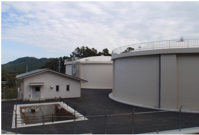
写真-1 畦町配水池完成写真
