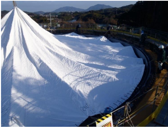
写真-3 膜吊込み状況
