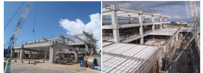
写真-8 PCa 部材架設状況
