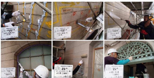
写真-2 外周部施工状況
