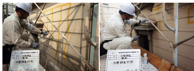
写真-1 外周調査状況
