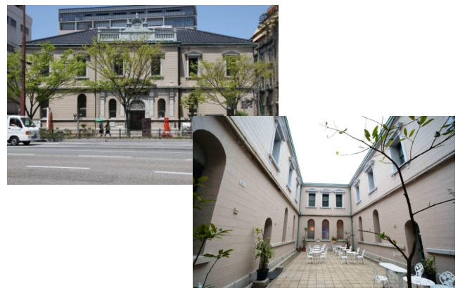
写真-4 外壁改修工事完了
