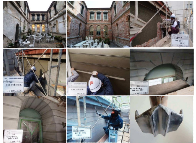
写真-3 中庭施工状況
