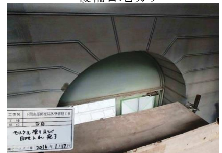
写真-50 窓廻り覆輪目地切り
