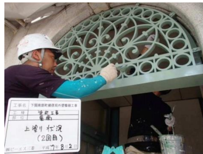
写真-36 欄干部塗装
