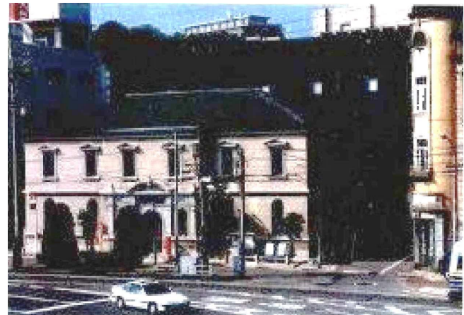
写真-6 平成9年以前の外観
