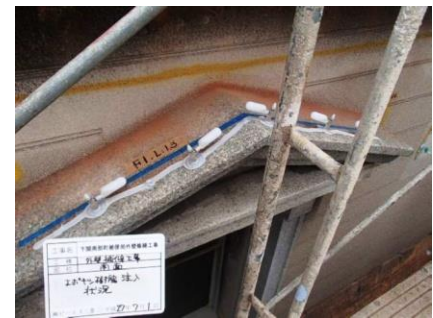
写真-31 石材部ひび割れ補修 (低圧エポキシ樹脂注入)
