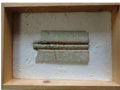
写真-54 既存覆輪目地 (保存)
