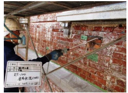
写真-44 浸透性アルカリ付与 固化増強剤塗布
