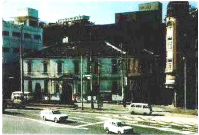
写真-5 昭和58年以前の外観
