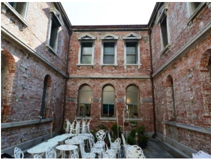
写真-42 既存漆喰撤去 ・高圧洗浄完了
