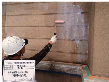
写真-33 シーラー塗布
