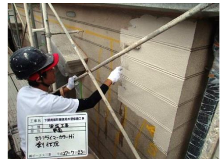
写真-34 プライマー塗布
