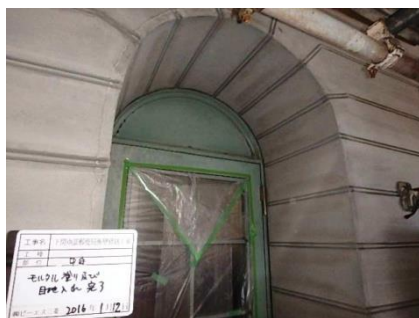
写真-51 目地切り完了
