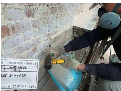
写真-39 既存漆喰はつきり落し
