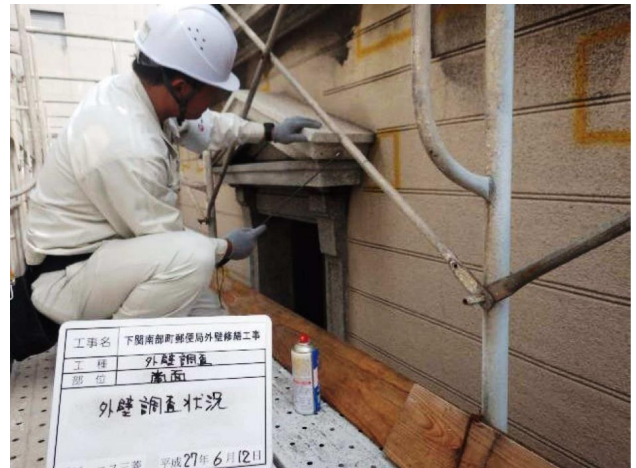
写真-13 調査状況
