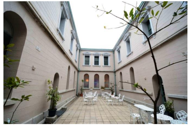
写真-57 中庭外壁改修工事完了
