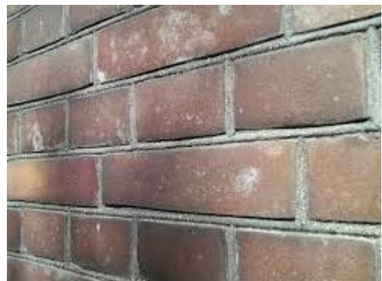
写真-38 タイルに使用された覆輪目地
