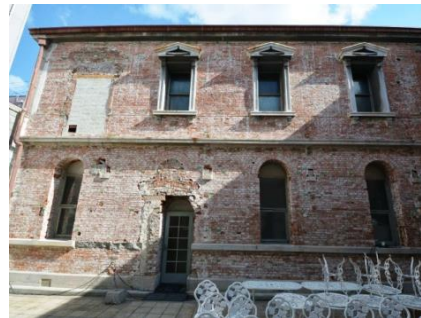
写真-43 既存漆喰撤去 ・高圧洗浄完了
