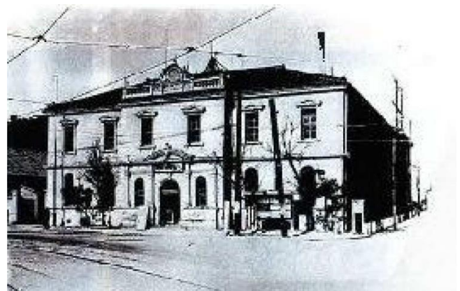
写真-4 昭和 24 年以前の外観
