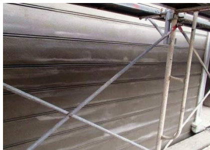
写真-48 覆輪目地完了
