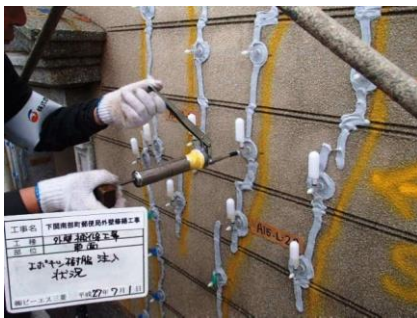
写真-29 外壁クラック補修 (低圧エポキシ樹脂注入)
