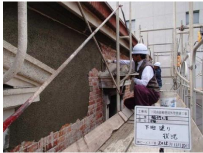
写真-45 モルタル下塗り
