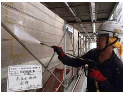
写真-32 高圧洗浄
