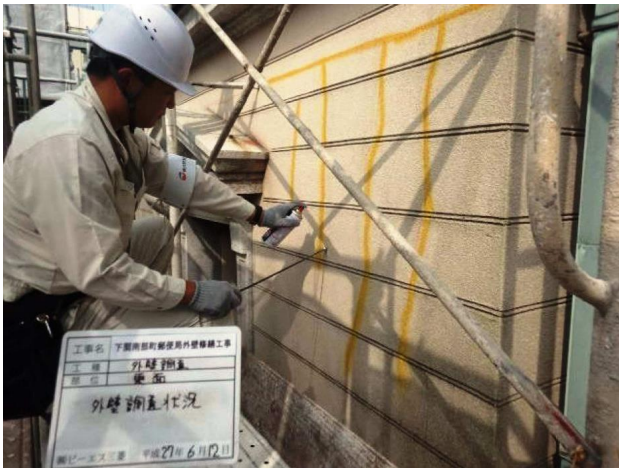
写真-12 調査状況
