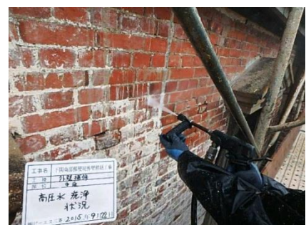
写真-41 高圧水洗浄
