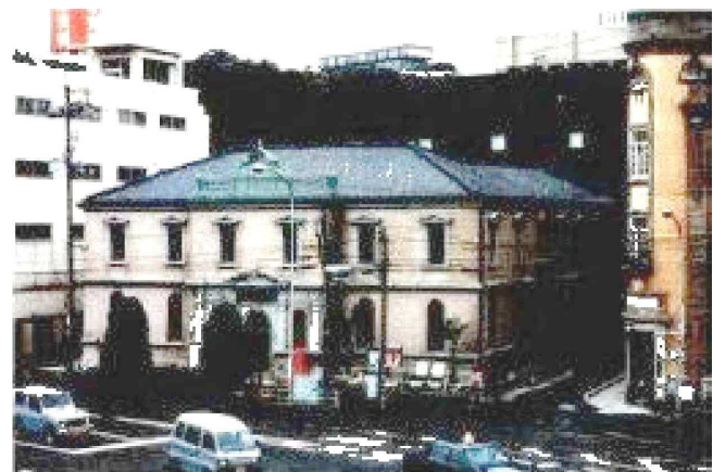
写真-7 平成11年改修後の外観
