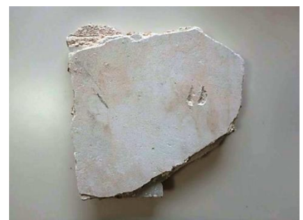
写真-56 既存漆喰壁 (保存)
