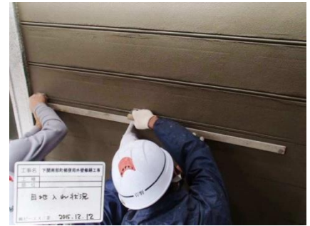
写真-47 モルタル上塗り後 覆輪目地切り
