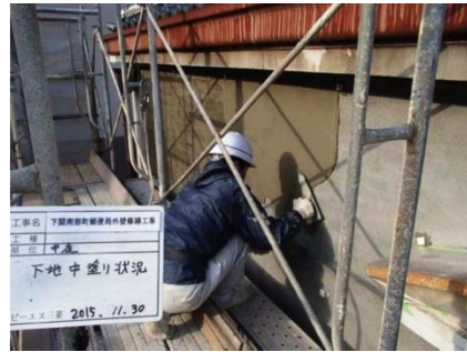
写真-46 モルタル中塗り
