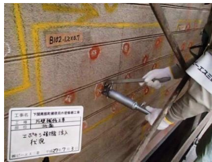
写真-30 モルタル浮き補修 (アンカーピンング部樹脂注入)
