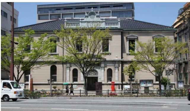
写真-1 改修工事前
