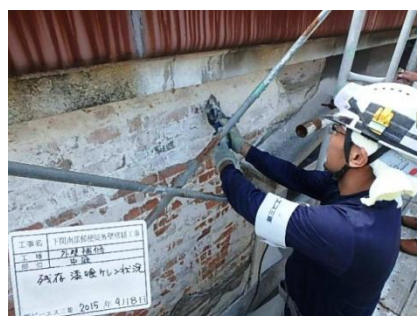
写真-40 残存漆喰ケレン掛け
