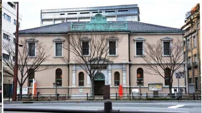
写真-2 改修工事後
