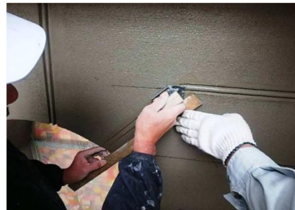
写真-49 覆輪目地斜め部
