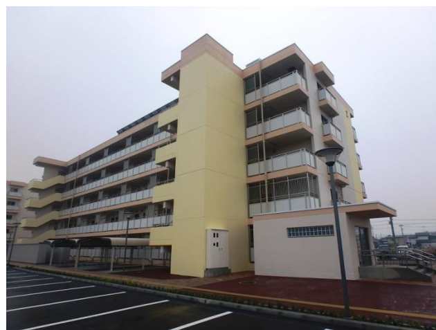
写真-1 2号棟北西側外観
