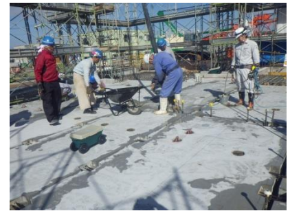
写真-8 充填コンクリート打設
