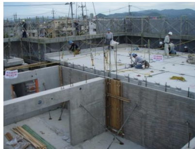
写真-22 ③～⑨床版 PCa 架設
