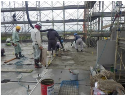
写真-30 床トップコン打設
