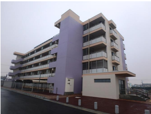
写真-33 3号棟北西側外観
