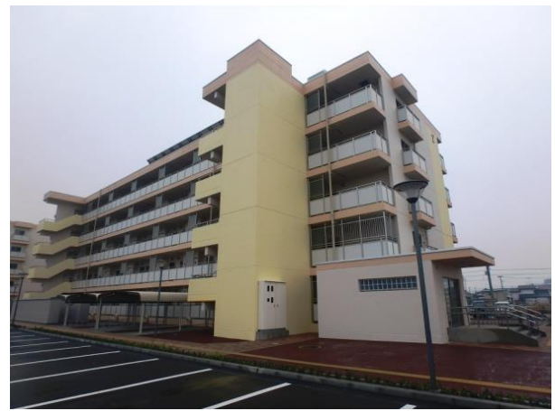
写真-1 2号棟北西側外観
