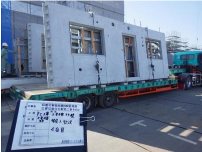
写真-15 壁板搬入
