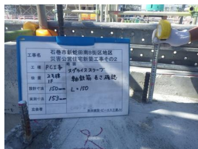
写真-10 軸筋長さ確認
