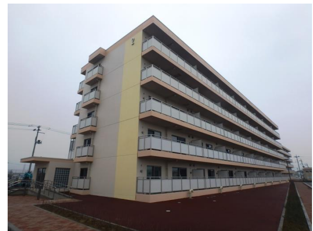
写真-2 2号棟南西側外観
