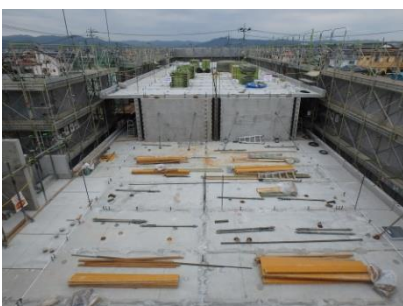
写真-24 ③～⑨床版 PCa 架設完了
