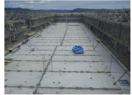
写真-32 コンクリート打設完了
