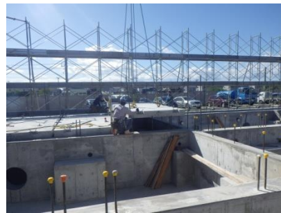
写真-7 1F床版PC架設
