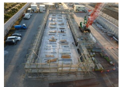
写真-11 1F床版PC架設完了
