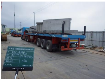
写真-12 階段搬入
