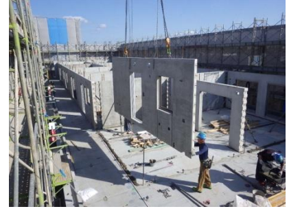
写真-17 壁板 PCa 架設
