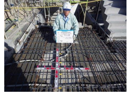
写真-29 ハーフ PCa 配筋確認
