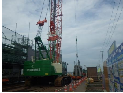
写真-16 揚重作業
