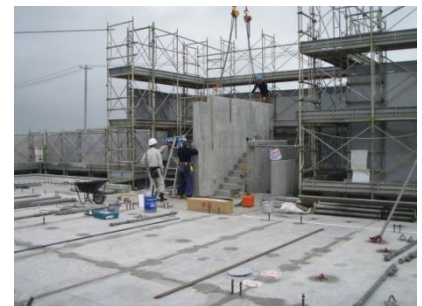
写真-14 EV 壁板 PCa 架設
