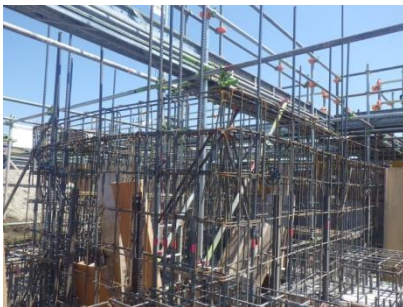
写真-3 軸筋設置
