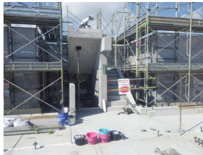
写真-13 階段 PCa 架設
