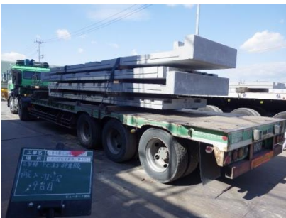
写真-21 床版搬入
