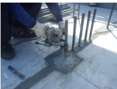
写真-9 軸筋切断
