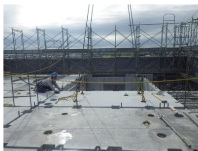
写真-25 ①～③床版 PCa 架設
