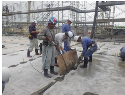
写真-31 充填コン打設
