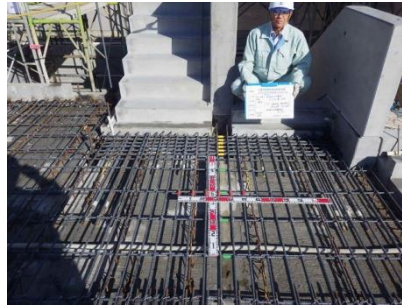
写真-28 ハーフ PCa 配筋確認
