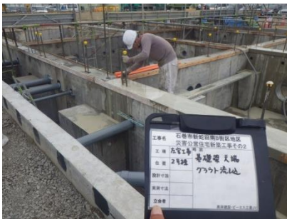
写真-6 グラウト流し込み
