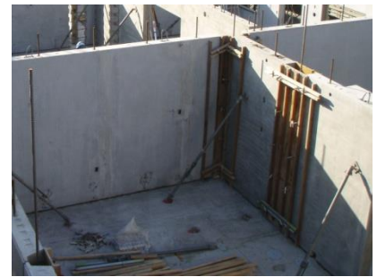
写真-20 ジョイント型枠組立
