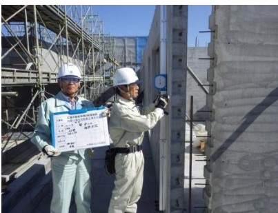
写真-18 壁板建入れ確認
