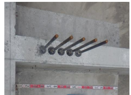
写真-5 型枠解体後
