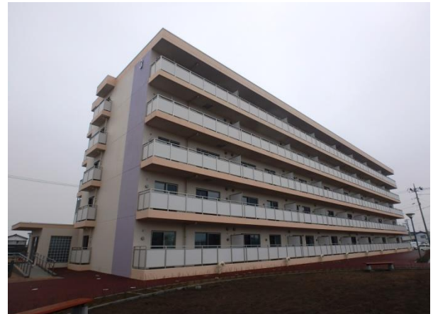
写真-34 3号棟南西側外観
