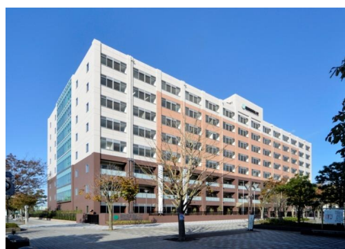
写真-1 建物外観
