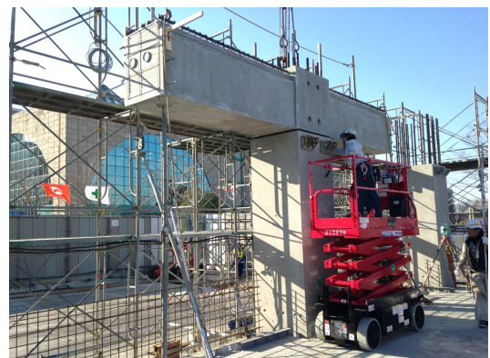
写真-2 桁梁（レンコン部材）架設状況
