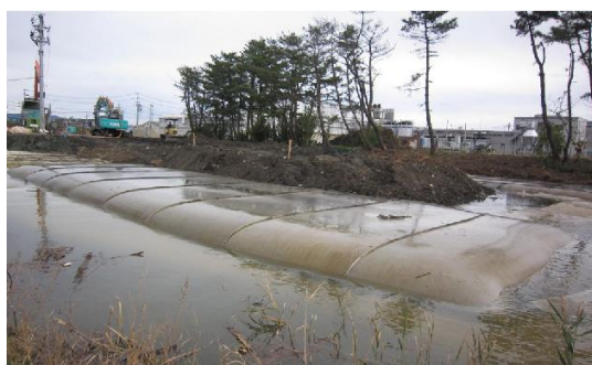
写真-4 100m 3 袋による水中盛土施工
