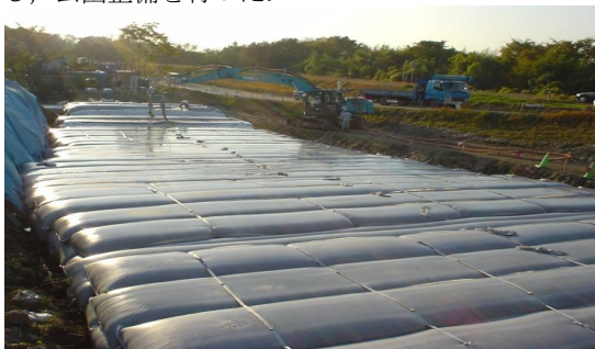
写真-3 遊休地への底泥による埋土
