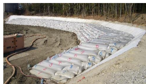
写真-2 築堤材料への有効利用
