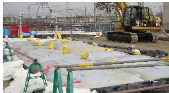
写真-5 ダイオキシン類汚染土処理状況
