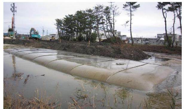
写真-22 100m<sup>3</sup>袋による水中盛土施工
