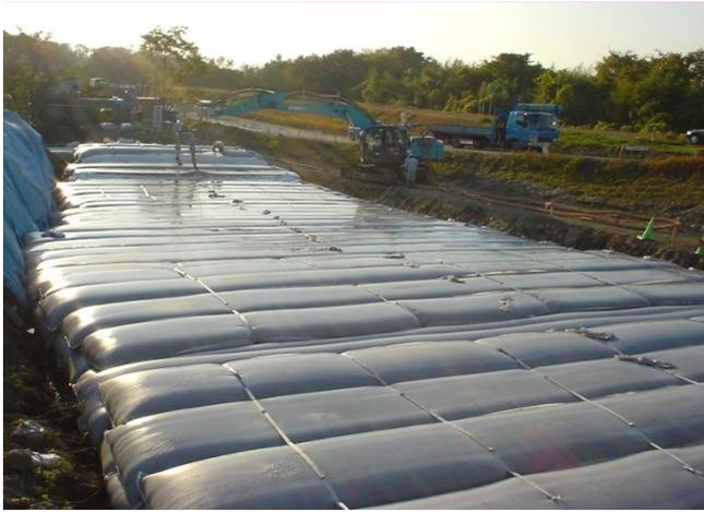
写真-17 遊休地への底泥による埋土
