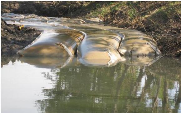
写真-21 水際での大型袋施工
