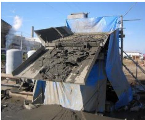
写真-5 定置型小型泥土前処理機施工状況
