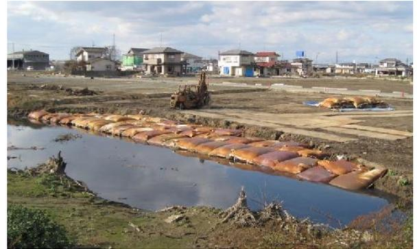
写真-20 用水路の法面崩壊箇所への復旧
