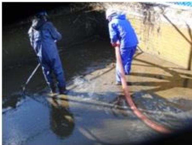
写真-3 バキューム車による底泥処理
