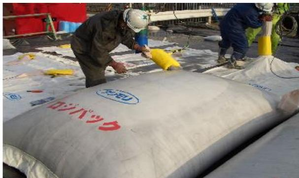
写真-13 ダイオキシン類汚染土充填袋
