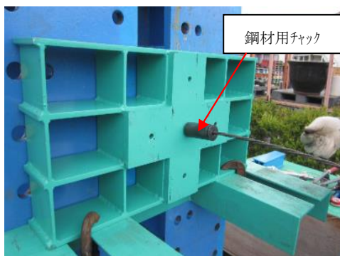
写真-12 アバットへのチャックの設置
