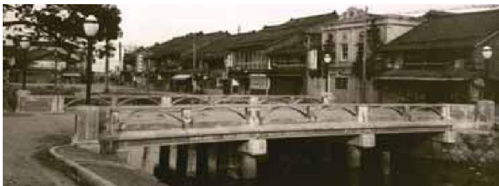
写真-1 日本初の PC 橋 長生橋
