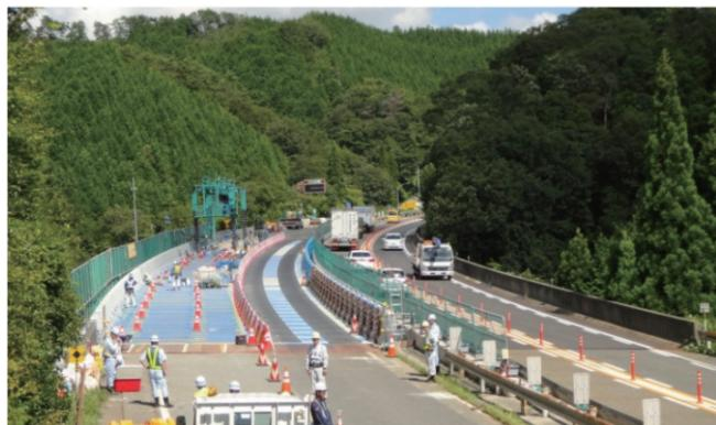
写真-1 PCaPC 床版架設状況
