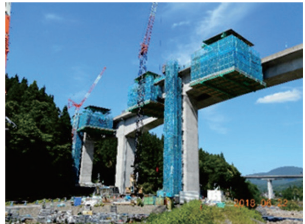
写真-3 張出し施工状況(P5～A2)
