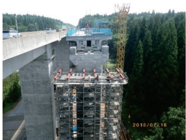
写真-4 側径間施工状況(P5～A2)
