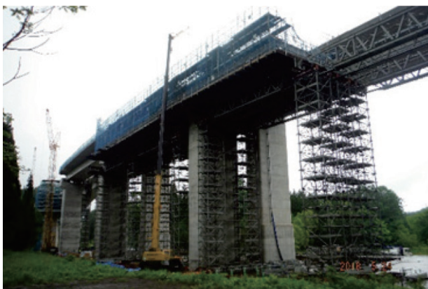
写真-2 施工状況写真(A1～P5)
