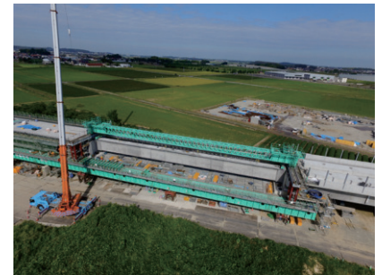
写真-2 主桁架設時全景
