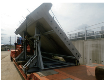
写真-1 ブロック桁の荷姿
