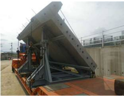
写真-1 ブロック桁の荷姿
