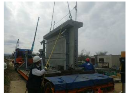
写真-3 ブロック桁の荷取り
