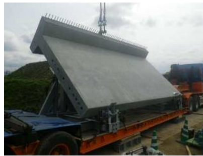
写真-2 ブロック桁の荷姿
