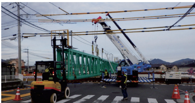
写真-1 手延べ桁解体状況
