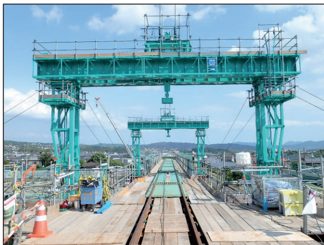
写真-2 100t吊り対応門型架設機
