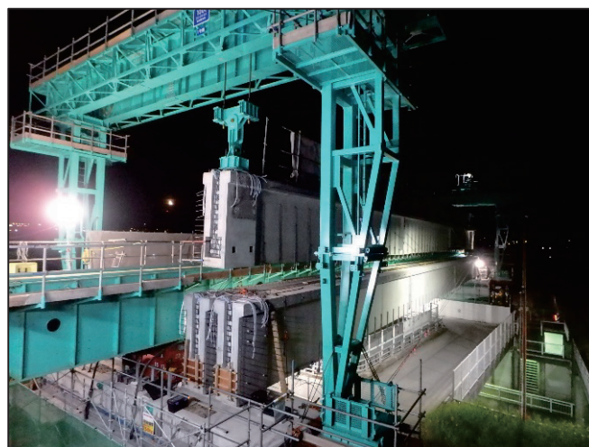
写真-4 架設状況
