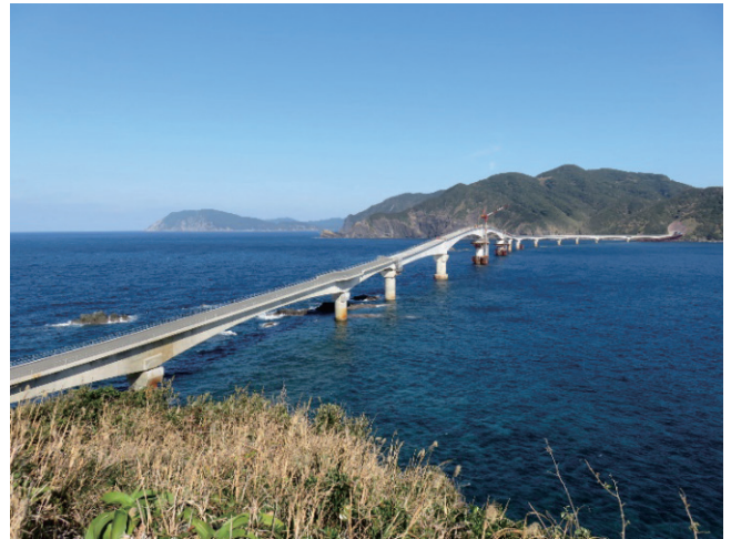
写真-1 蘭牟田瀬戸架橋全景 (2020.1~起点側より望む)
