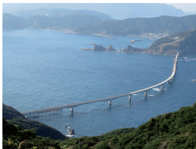
写真-2 藪牟田瀬戸架橋全景(2020.1~終点側より望む)
