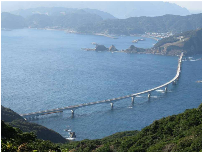
写真-6 蘭牟田瀬戸架橋全景 (2020.1～終点側より望む)
