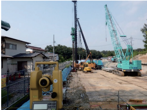
写真-3 トランシットによる鉛直精度確認
