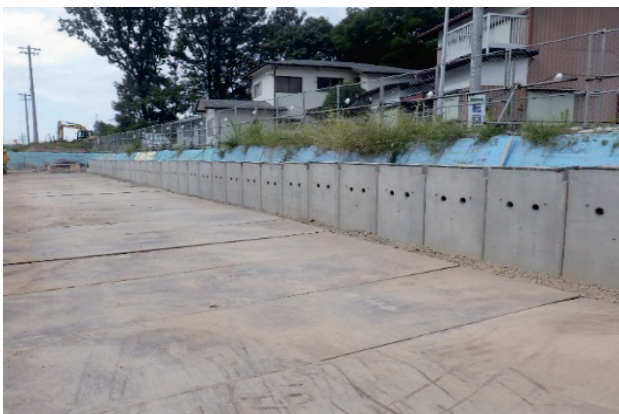
写真-1 完成写真
