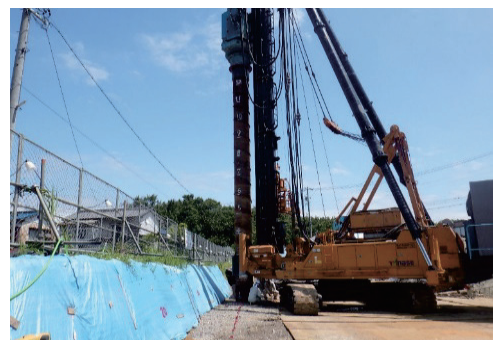
写真-2 先行削孔状況
