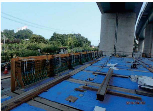
写真-1 フルキャスト壁高欄製作状況
