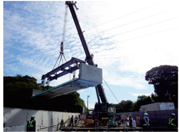
写真-2 床版架設状況
