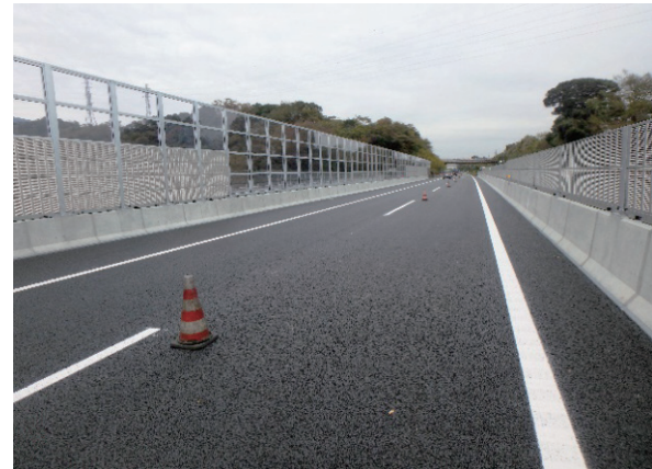
写真-3 工事完了 (交通規制解放前)
