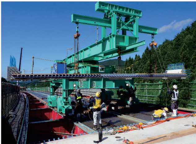
写真-4 PCaPC 床版架設状況
