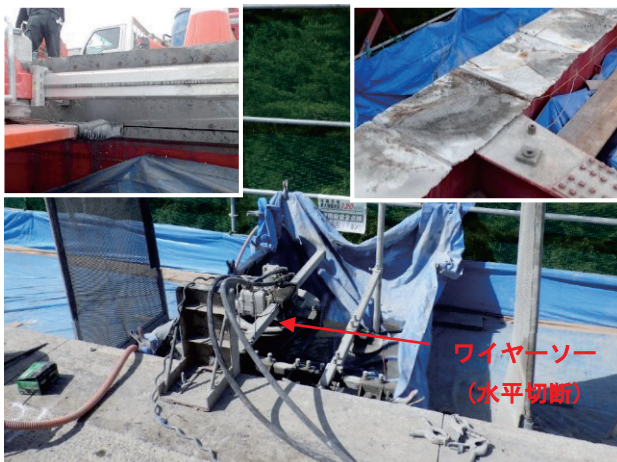
写真-5 既設 RC 床版撤去状況(水平切断)
