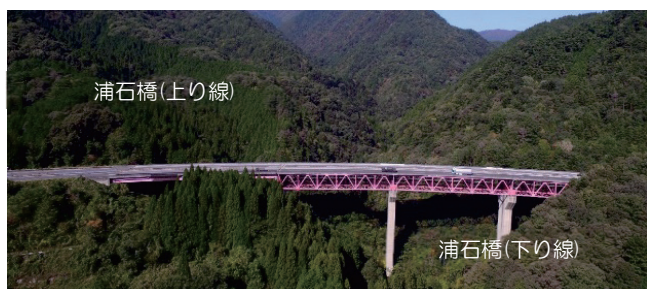
写真-2 浦石橋全景
