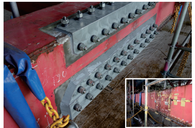
写真-6 当て板補修状況
