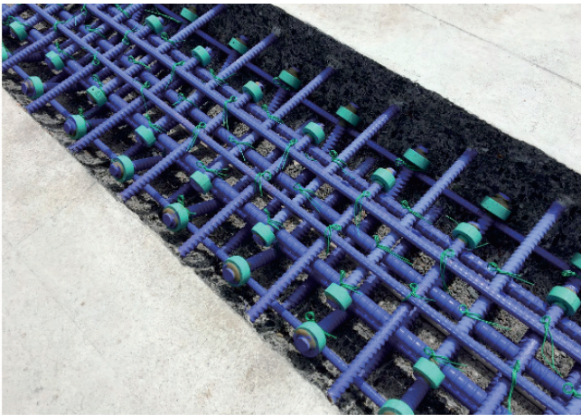
写真-3 MuSSL 工法継手
