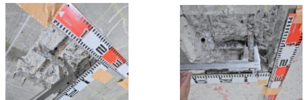
写真-3 鉄筋腐食量調査状況
