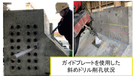
図-2 挿入兼注入孔形成手順
