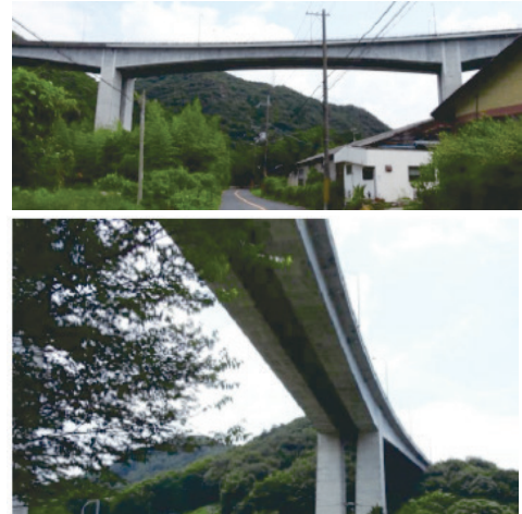
写真-1 PC 鋼棒を有する PC 箱桁橋の一例
