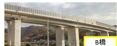
写真-1 PC 鋼棒を有する PC 箱桁橋
