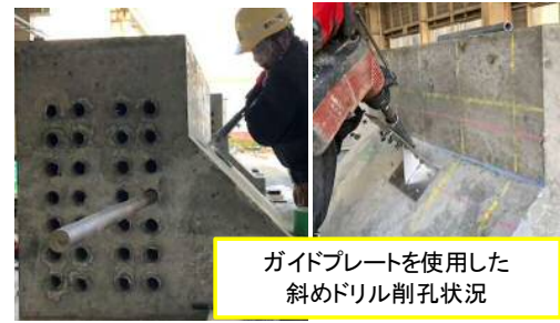
写真-3 削孔試験状況
