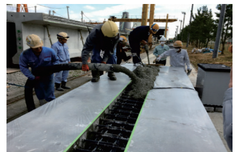
写真-1 FA コンクリート打設状況
