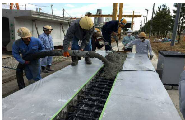
写真-1 FAコンクリート打設状況
