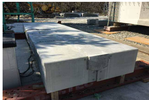
写真-2 端枠脱枠後状況
