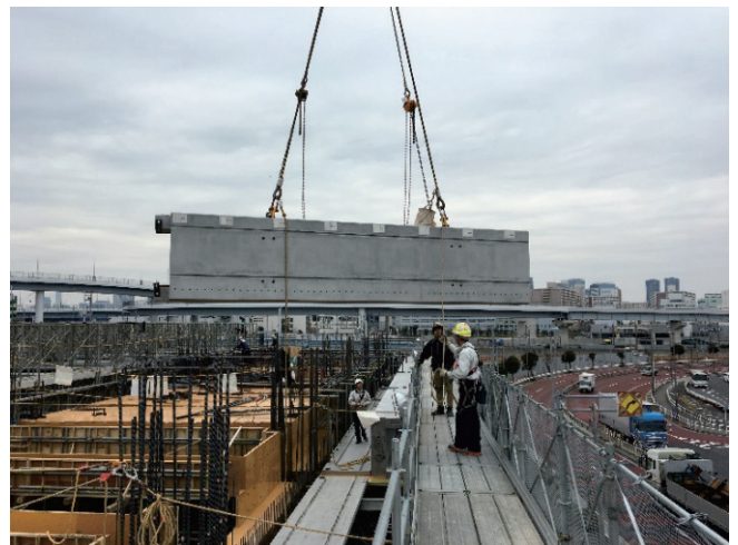
写真-2 架設状況
