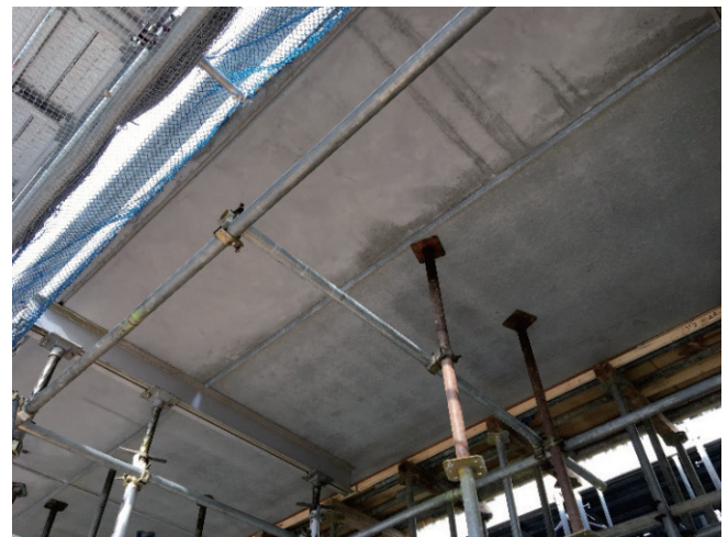
写真-3 架設状況
