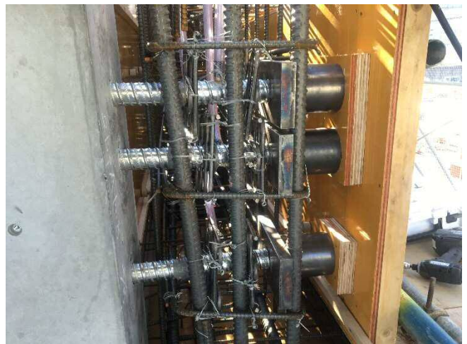
写真-10 現場打ち部定着体収まり
