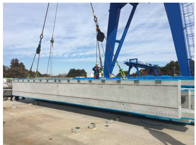
写真-6 試験吊り
