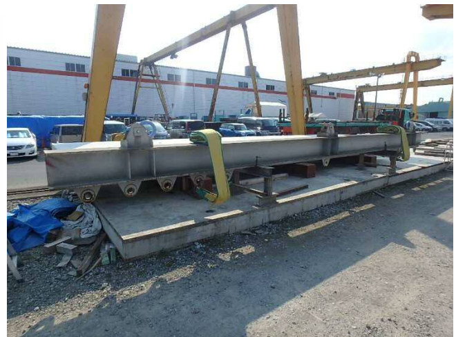
写真-3 吊り天秤
