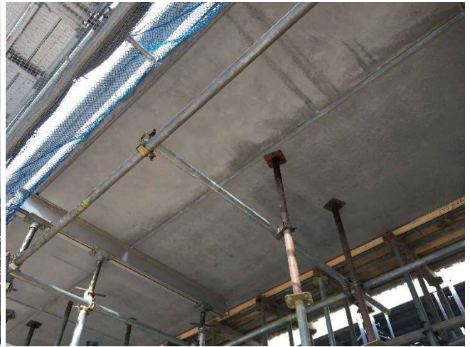
写真-8 部材下面の調整
