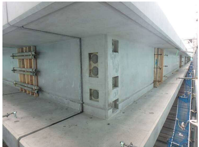
写真-2 隅部定着体収まり
