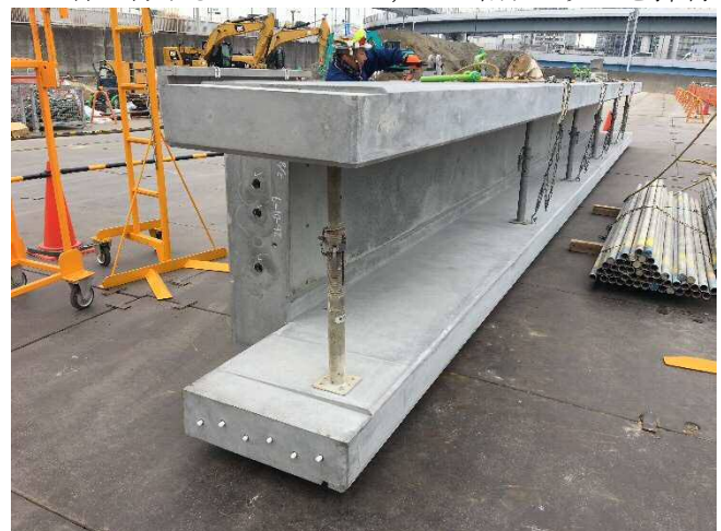
写真-4 養生用パイプサポート
