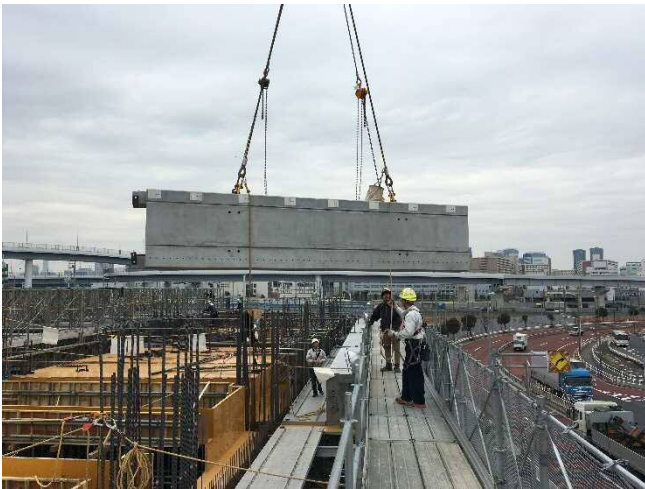
写真-7 架設状況
