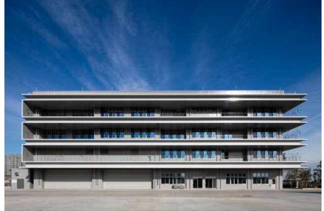
写真-1 建物外観 (©カ・ドーロ撮影)
