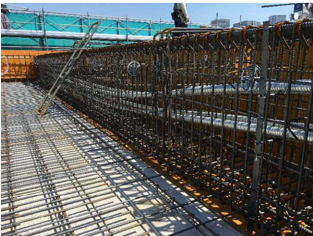
写真-11 場所打ち梁配線状況
