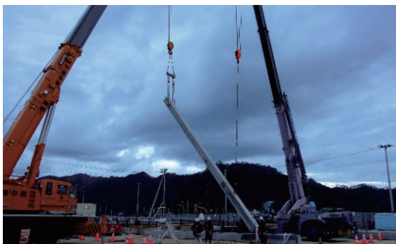
写真-3 建て起こし状況
