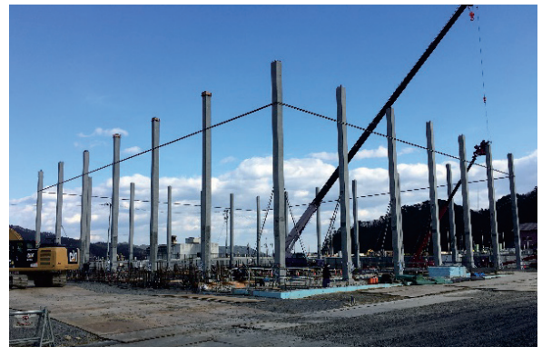
写真-5 建て入れ完了
