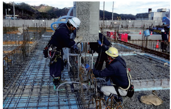
写真-4 柱架設状況
